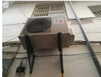
7.2kW 分離式冷氣機
